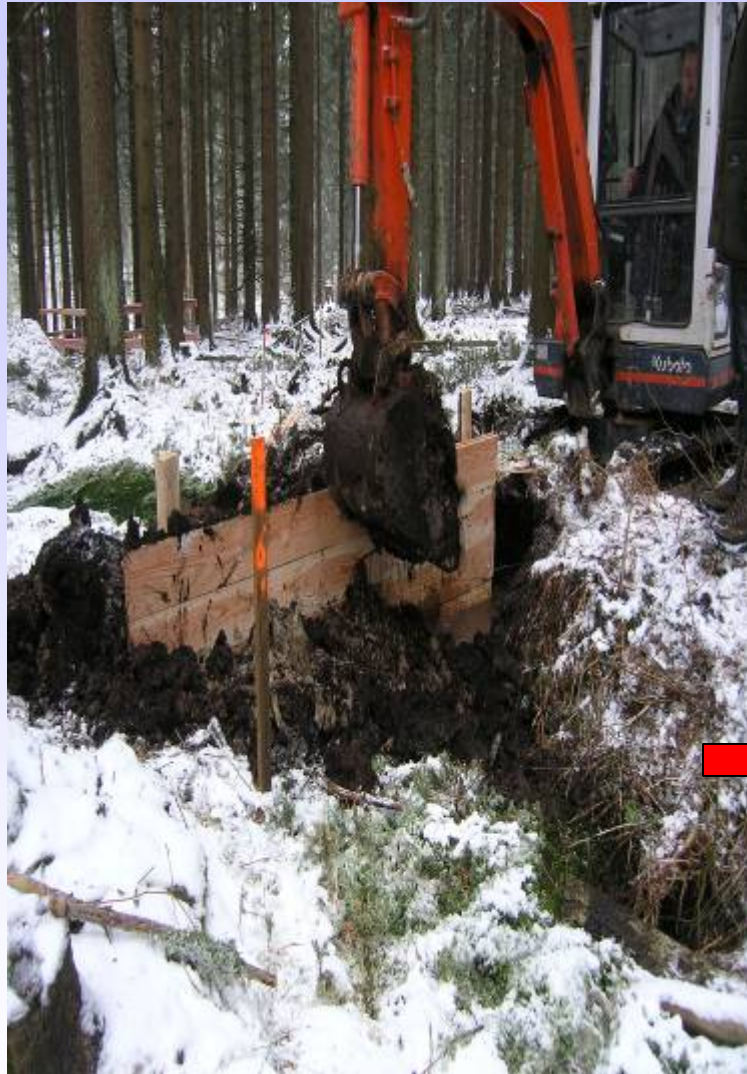
Bau eines „Bretterdamms“
